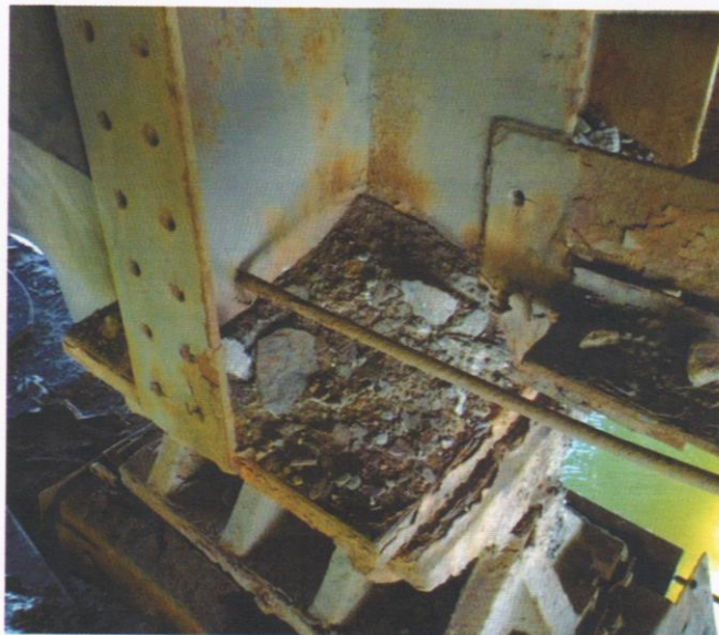
Рис. 13. Скупчення сміття на кінцях прогонових споруд у зоні деформаційного шва
