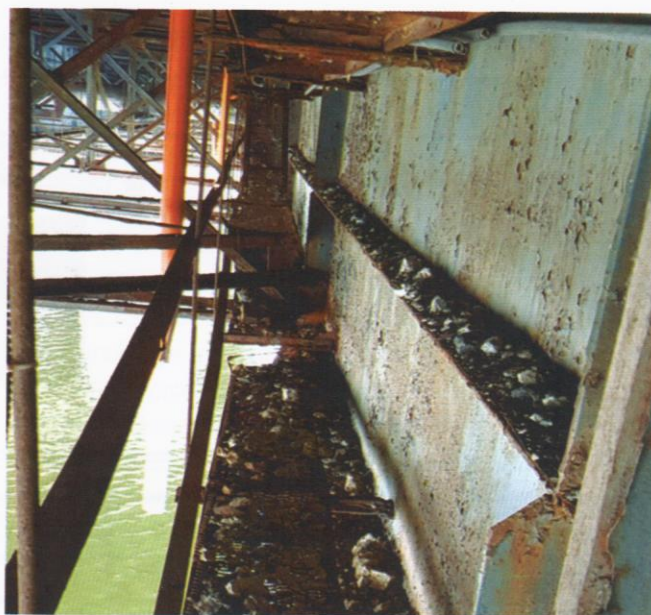
Рис. 12. Скупчення сміття на крайній балці № 4 першої п'ятипрогової споруди моста
