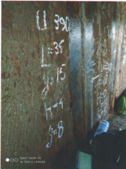
Рис. 5. Контроль стикових вертикальних швів з'єднувальної вставки
