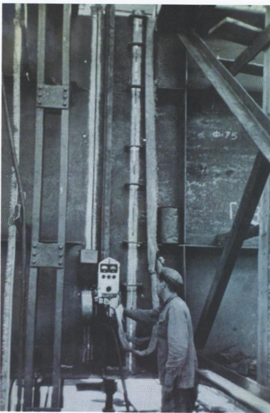
Рис. 2. Приклад застосування автоматичного зварювання під шаром флюсу при стикуванні ферм головних балок [2]
